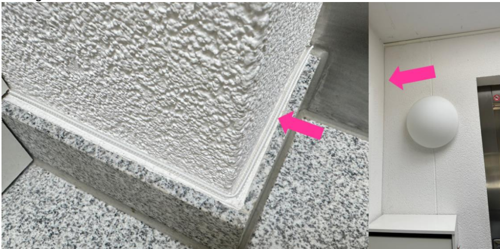
Abbildung 50: „Clear Track“ in einem Treppenhaus installiert (Foto: Zerson)
