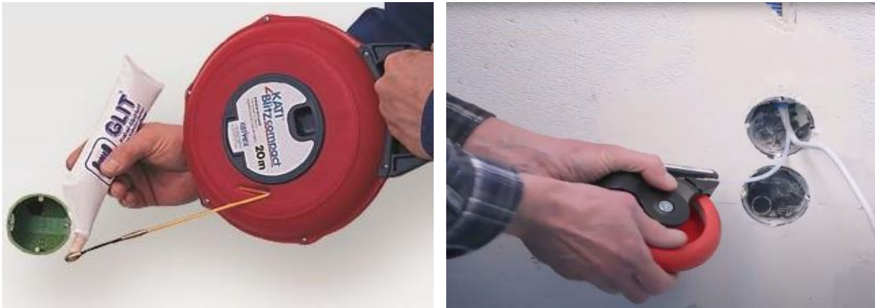
Abbildung 11: Auftragen von Kabelgleitmittel und Einziehgerät für belegte Leerrohre (Quelle: Fa. KATIMEX®)
