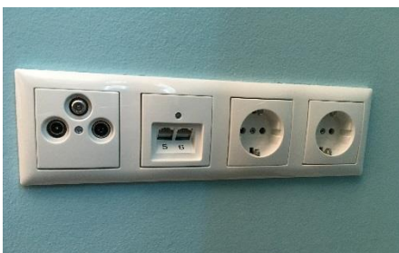
Abbildung 62: Mögliche Konfiguration von Wandauslässen (Koax, Daten und Strom) (Quelle: DT)
