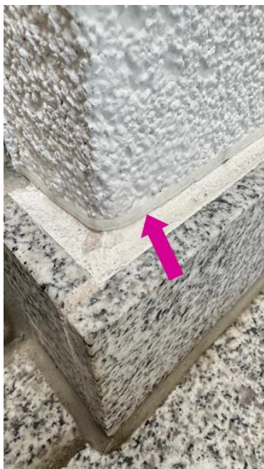
Abbildung 52: „Selbstklebende Faser“ in einem Treppenhaus installiert (Foto: Zerson)
